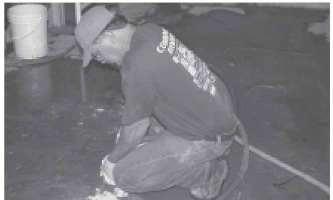
PÅFØRSEL PÅ BETONPLADE: Injicér BENTOGROUT under en eksisterende plade for at sikre vandtætning og fyldning af hulrum
