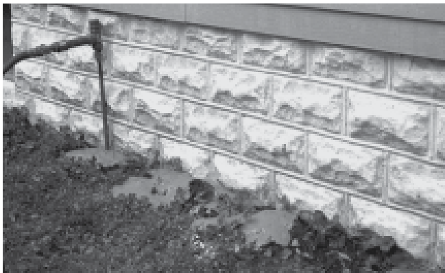
PÅFØRSEL PÅ DEN UDVENDIGE SIDE AF MURVÆRK: Injicér BENTOGROUT langs den udvendige side af en fundamentvæg med en centerafstand af 600 mm
