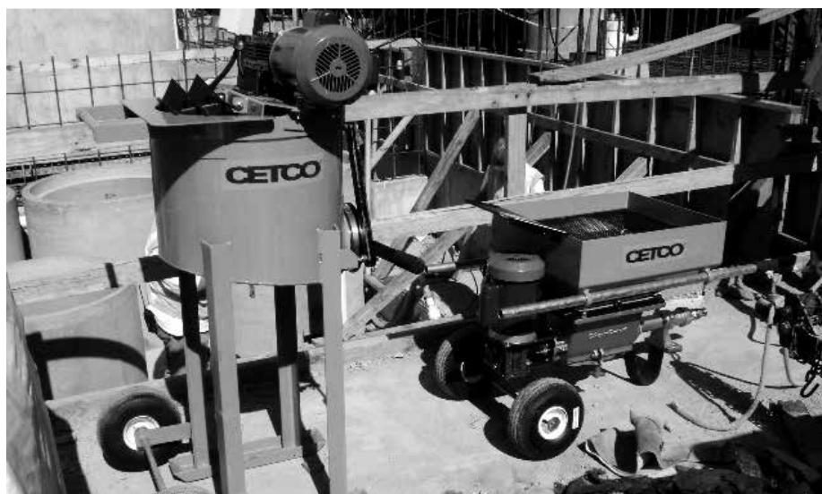
Figur 2: CETCO-pumpe og blander med 1hk el-motor
