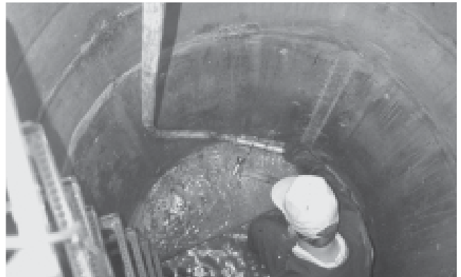
INDVENDIG PÅFØRSEL IGENNEM VÆG: BENTOGROUT injiceres til den udvendige side af et mandehul igennem for-borede huller ved hjælp af en kort injektionsstav
