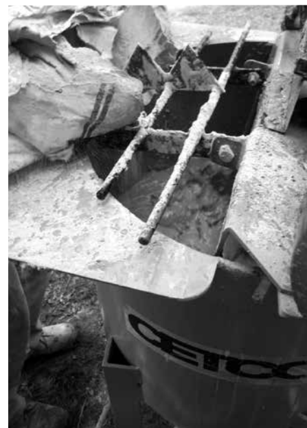
Blanding af BENTOGROUT i CETCO-blander
